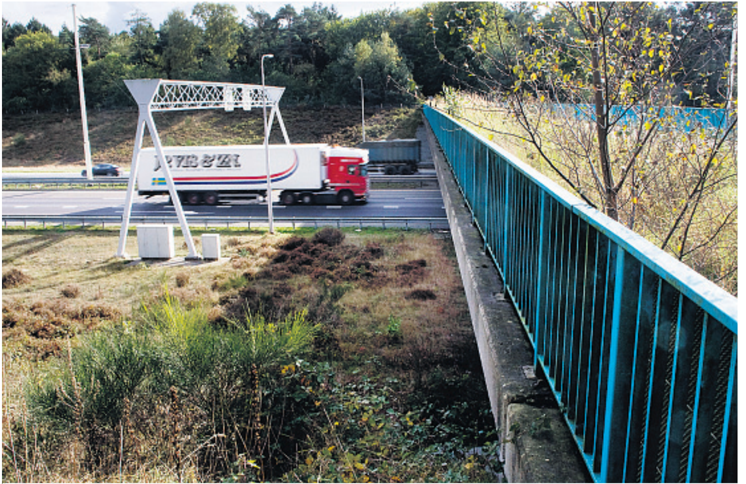
Viaduct voor dieren over de A28 bij Zeist. Strengere aanbestedingsregels zetten mkb'ers op achterstand bij dit soort werken.
